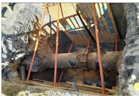
Figura 28 – Estado da conduta após abertura de vala
