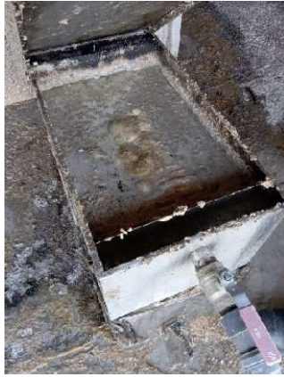
Figura 16 - Separador de Gorduras Colmatado
