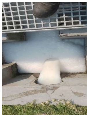
Figura 14 - Verificação de descarga não autorizada na rede
