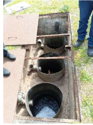
Figura 17 - Separador de Hidrocarbonetos (a necessitar de limpeza)
