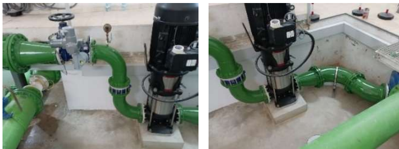
Figura 24 - Instalação dos novos grupos eletrobombas e todas as válvulas
