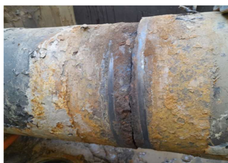
Figura 29 – Remoção da junta de ligação tubo existente
