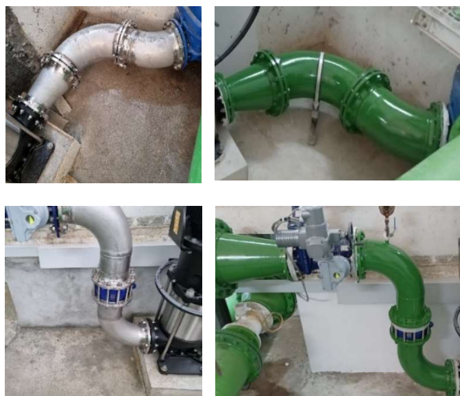
Figura 23 - Instalação dos novos circuitos hidráulicos, eletrobombas e válvulas
