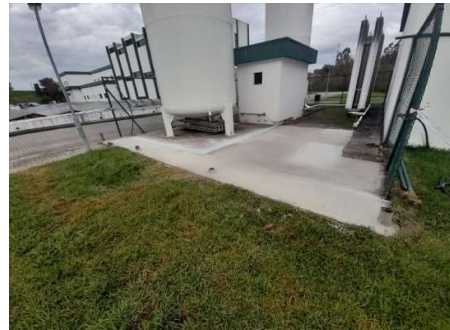
Figura 34 – Nova base de assentamento
