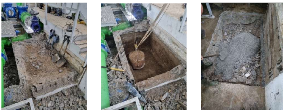
Figura 22 - Demolição dos Maciços de Suporte das Bombas Originais e Construção de novos Maciços
