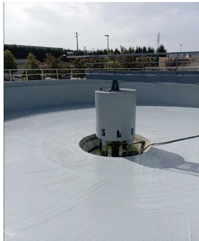
Figura 42 - Decantador Primário
