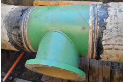
Figura 30 – Colocado novo troço de tubagem
