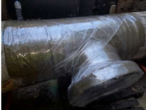
Figura 32 – Conduta revestida/Protegida com fita isolantes para proteção anticorrosiva
