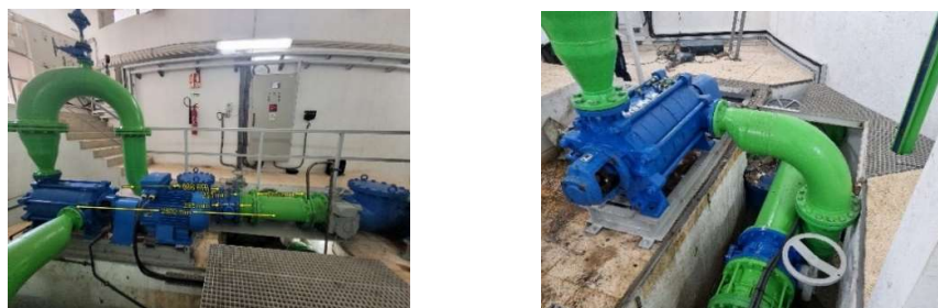
Figura 21 - Desinstalação das Eletrobombas Instaladas há 26 Anos
