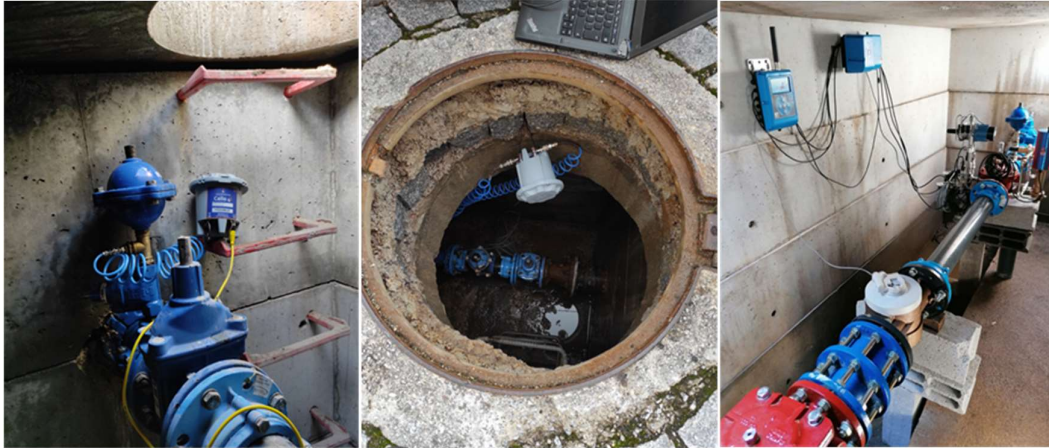
Figura 11 - Manutenção das Válvulas Redutoras de Pressão
